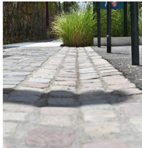
CANIVEAU INFILTRANT RUE SŒUR VALÉRIE, VILLE D'ASNIÈRES.
