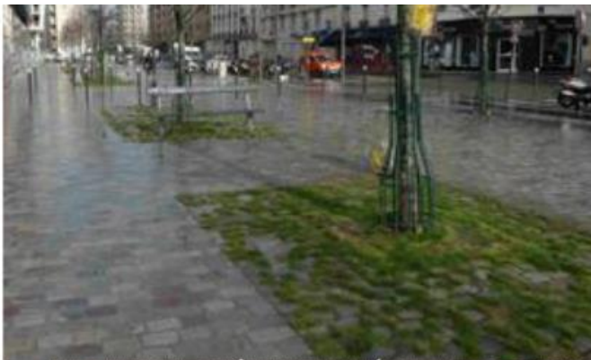
RUE CARDINET : REVÊTEMENT PERMÉABLE EN PIED D'ARBRE.
