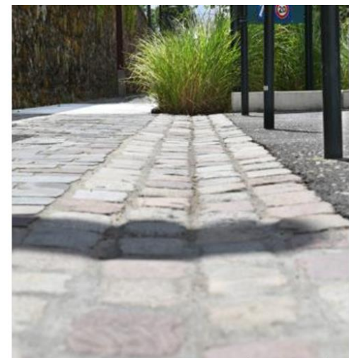
CANIVEAU INFILTRANT RUE SŒUR VALÉRIE, VILLE D'ASNIÈRES. Source : QUATREINGOUZE / AESN
