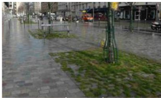
RUE CARDINET : REVÊTEMENT PERMÉABLE EN PIED D'ARBRE. Source : © APUR
