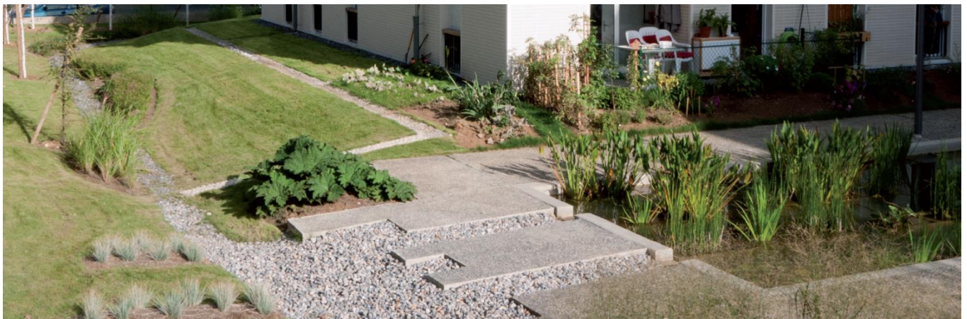
Gecombineerde beheertechnieken: wateropvanggoten die naar infiltratiesleuven en vervolgens naar een met grind gevuld infiltratiebed voeren. De afvoer is een waterbekken (Ivry-sur-Seine - Composante Urbaine - Studie naar vernieuwende projecten inzake regenwaterbeheer in de openbare ruimte en op de weg).
