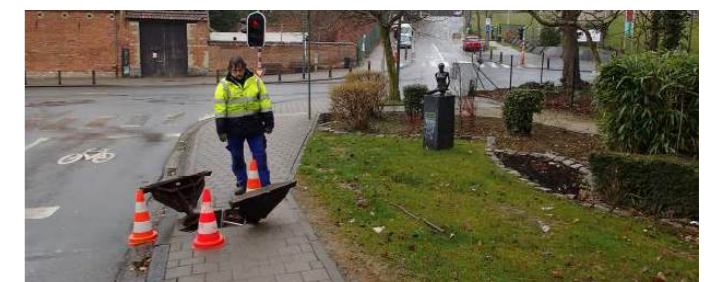
Chambre de visite CV5 depuis le pertuis (3)
