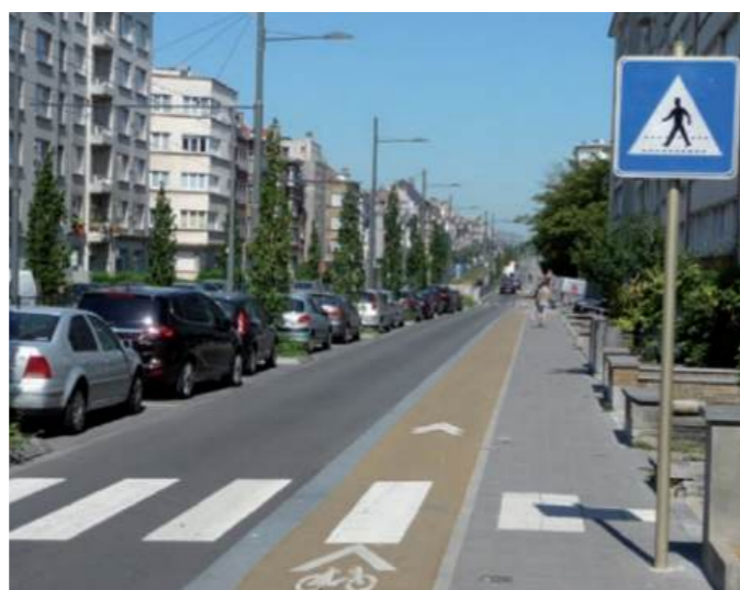
Asphalte gris conservé en voirie et asphalte coloré et marquages vélos pour la piste cyclable
