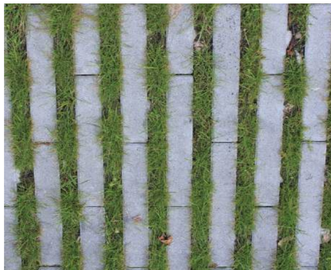
Dalles engazonnées carrossables
